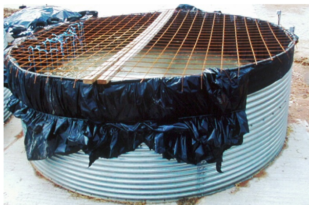
5 pav. Ruošiama kietos dangos paviršius.
